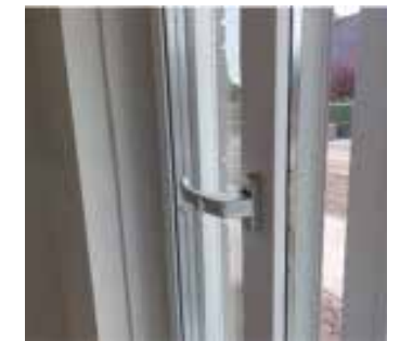
Werking draai-/kiepraam: stand hendel opzij, draai stand.
