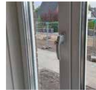
Werking draai-/kiepraam: stand hendel naar beneden, raam gesloten.
