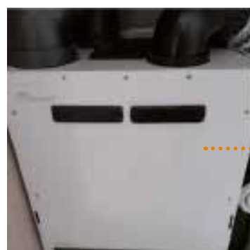
Ventilatiebox met uitschuifbare filters
