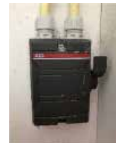
Werkschakelaar nabij omvormer
