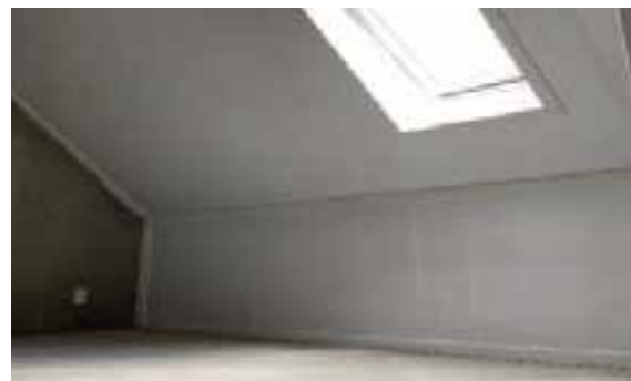
Dakplaten en knieschotten (eengezinswoningen).
