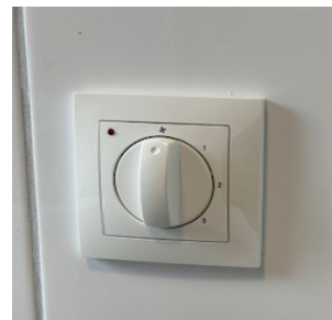
Schakelaar ventilatie
