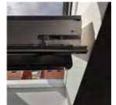
Vastzetpal dakraam, schuif deze naar rechts om het raam vast te zetten.
