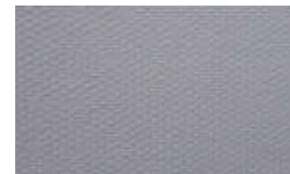
De wanden in uw woning zijn (mogelijk) voorzien van glasvezelbehang
