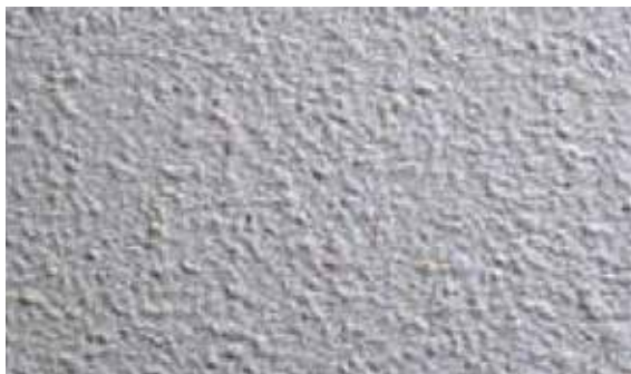
Spuitwerk op het plafond
