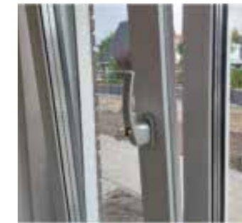
Werking draai-/kiepraam: stand hendel naar boven, kiep stand.
