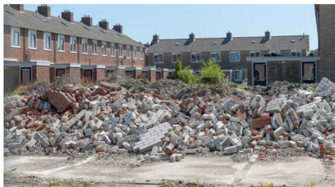
SLOOPWERKZAAMHEDEN AAN DE RENGERSSTRAAT EN GRAAF EDZARDSTRAAT IN APPINGEDAM
